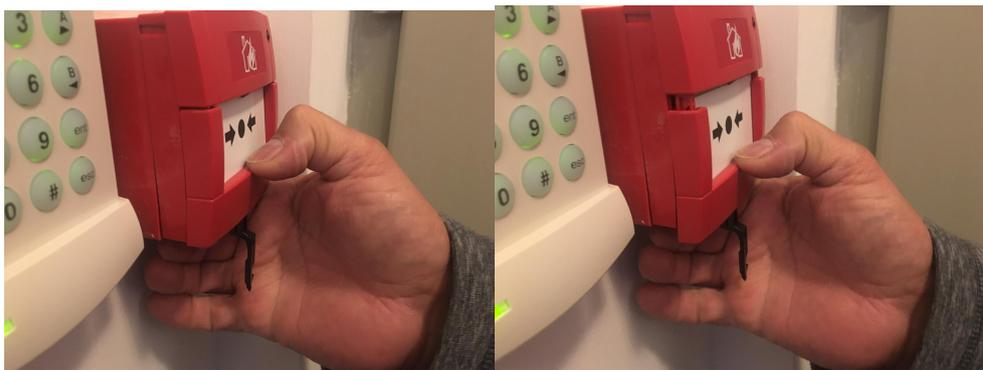
3) Remettre la petite plaque blanche en place et refermer le clapet. La clé noire n'est pas nécessaire pour cette opération.
